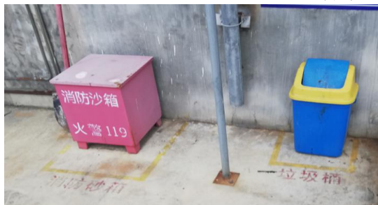
垃圾筒及消防沙箱（小）
