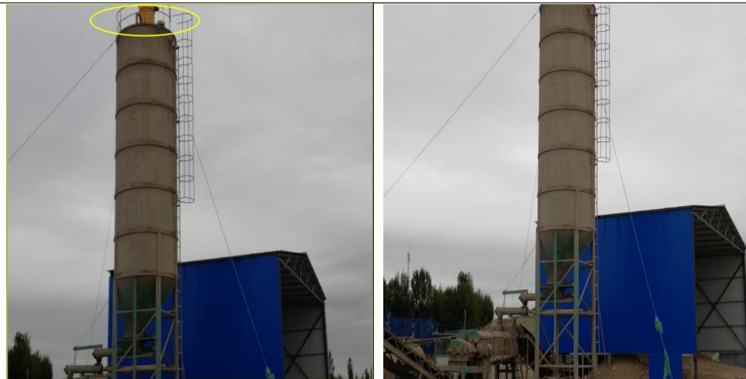
水稳材料生产线及滤筒式除尘装置
