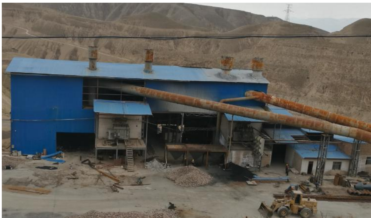
矿热炉生产车间及烟道
