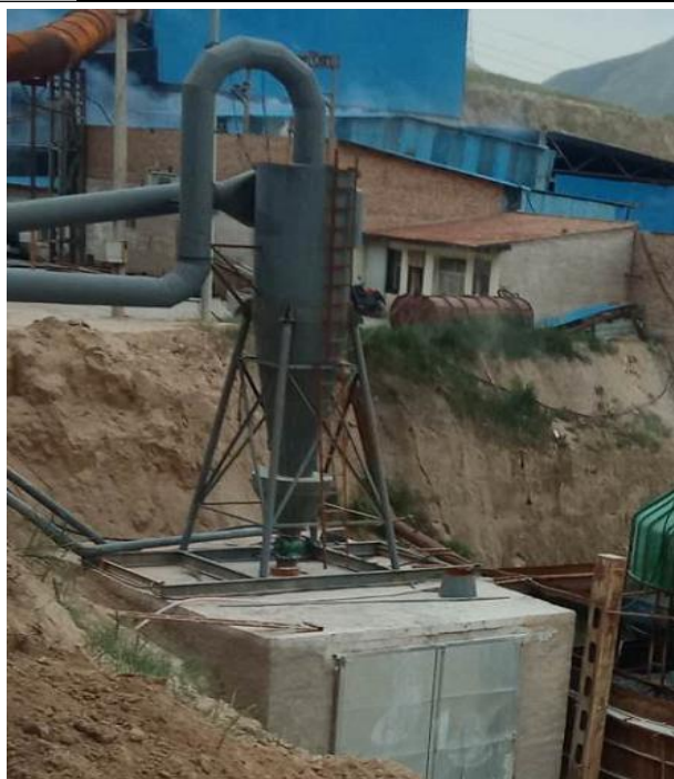
旋风除尘+灰尘沉降室
