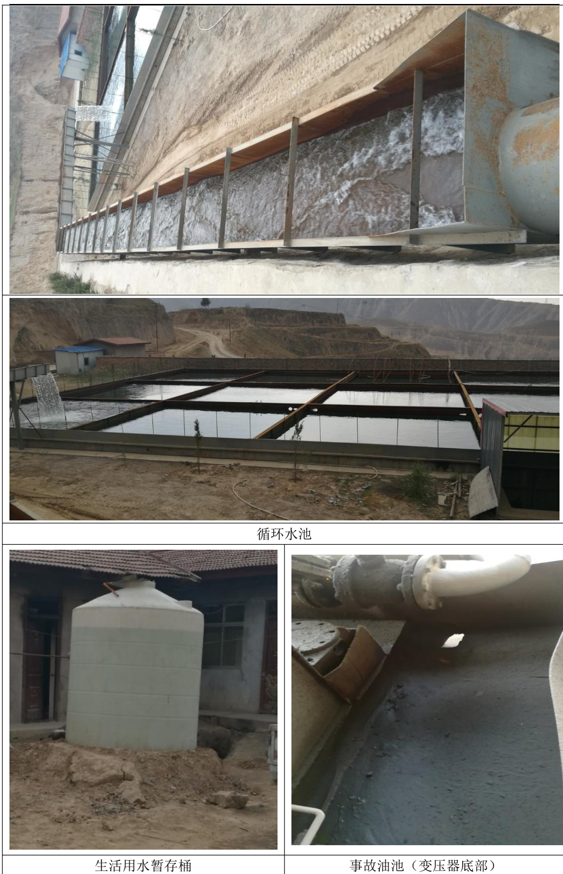
图 3-4 建设项目工程组成图
